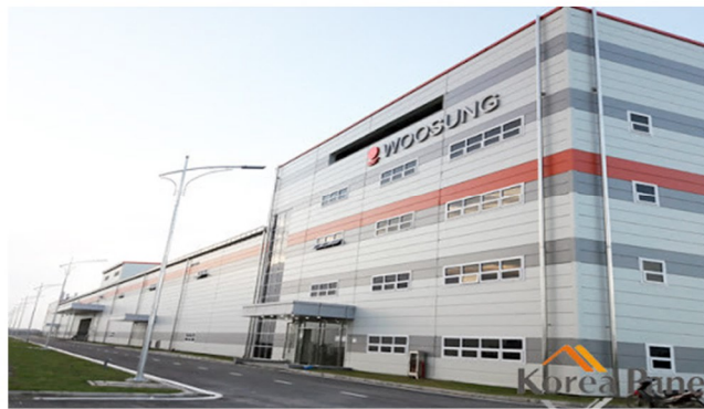
Nhà máy WOOSUNG
