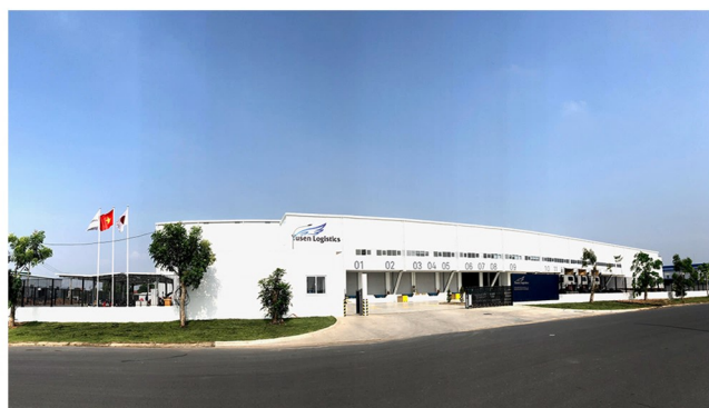
Công Trình YUSWN LOGISTICS
