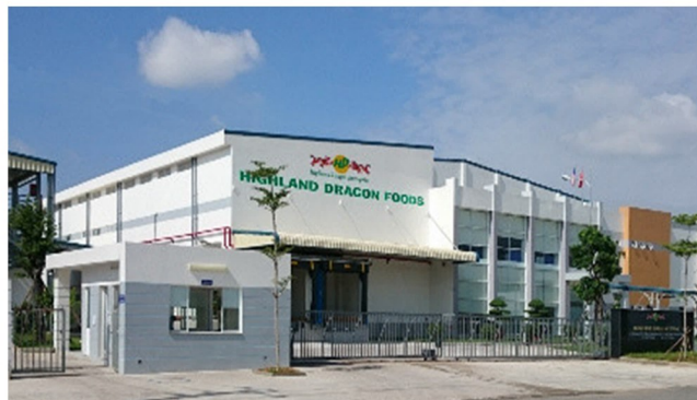
Nhà máy HIGHLAND DRAGON
